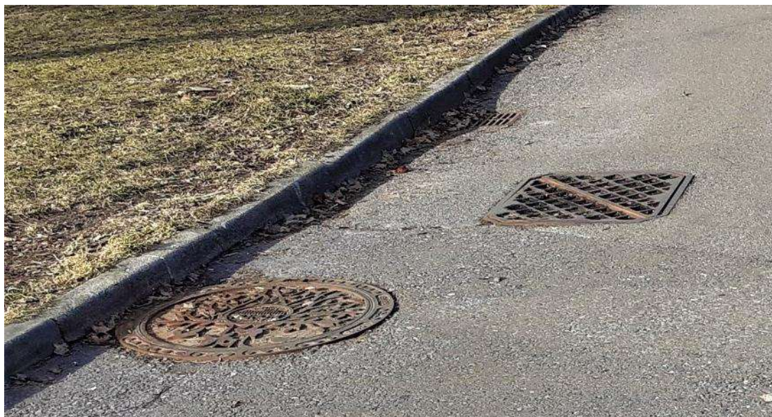
Foto 3.5.1.: Nyere flydende brønd, og ældre fast brønd, med nedløbsrist bagved.
