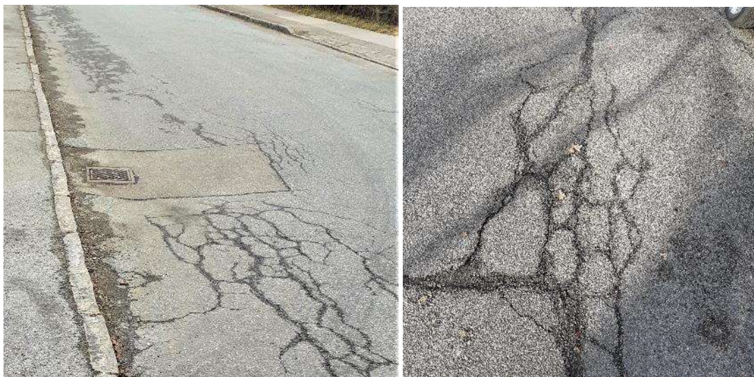
Foto 3.2.2.1.: Eksempler på krakeleringer, revner i partier.
