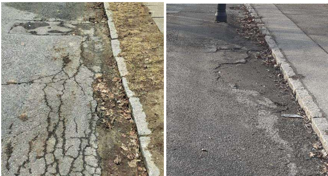
Foto 3.3.1.: Eksempler på afskalninger/opbrydning af vejbane.
