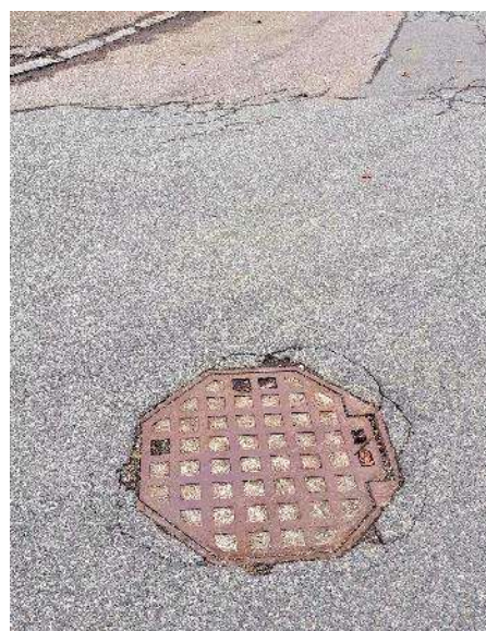
Foto 3.5.1.: Nyere flydende brønd, og ældre fast brønd, med nedløbsrist bagved.
