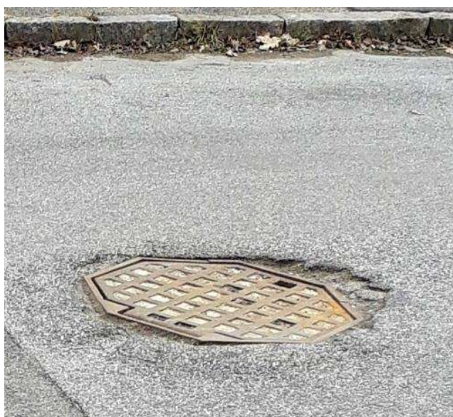
Foto 3.5.1.: Nyere flydende brønd, og ældre fast brønd, med nedløbsrist bagved.
