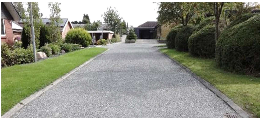
Foto 4.3.1. : Eksempel på overfladebehandling med 5/8 mm skærver, udlagt på boligvej
